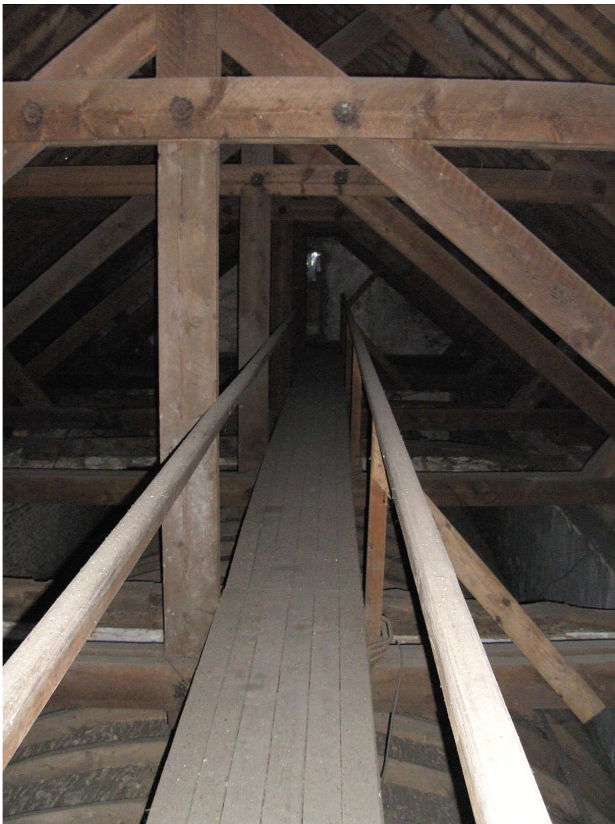
Figuur 42 - de loopbrug over het middenschip, en naar de horlogekamer
